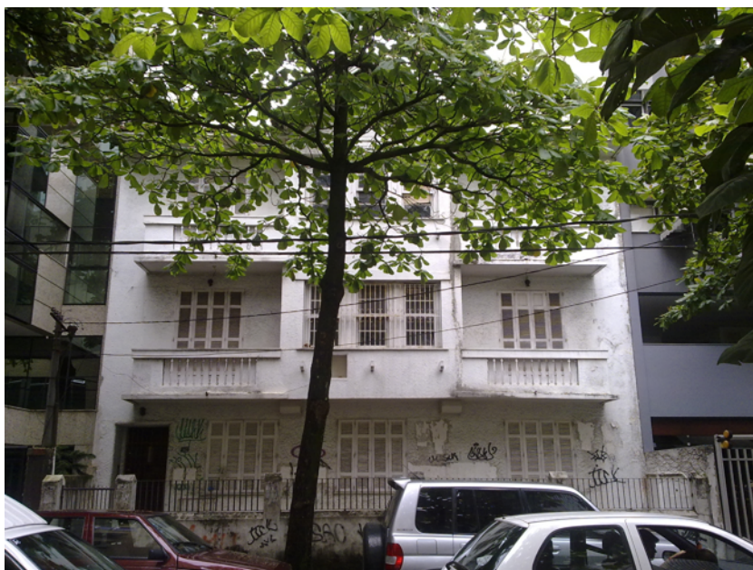
Figura 6: Encontramos uma série de edifícios que demonstram ter sido esvaziados com a intenção de demolição. Somente nesta pequena quadra, dois foram identificados! Porém, por algum motivo (APAC?), estes permanecem em estado de abandono, pichados e deteriorados, não sendo nem demolidos, nem ocupados. (Rua João Lira, entre ruas Humberto de Campos e Ataulfo de Paiva)
