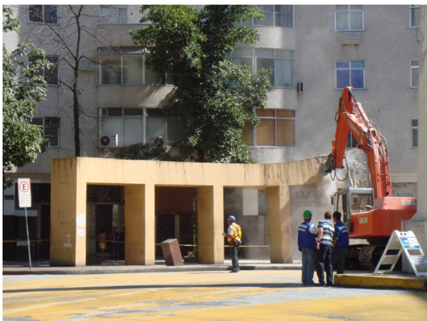
Figura 8: Uma das primeiras providências da atual gestão da prefeitura, a demolição da passarela em torno do obelisco de Ipanema, criada à época do projeto Rio-Cidade (1996) foi bastante reivindicada pelos moradores. Apesar da denominação “passarela”, nunca funcionou como tal, se tornando um obstáculo visual e base para intervenções de cartazes e pichações. (Rua Visconde de Pirajá, junto à rua Henrique Dumont)
