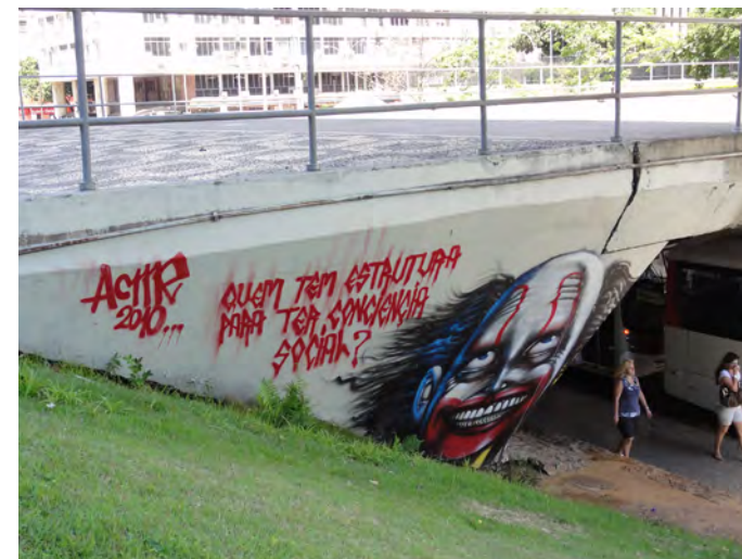
Figura 47. Passarela sobre a av. República do Chile. (05.11.11)
