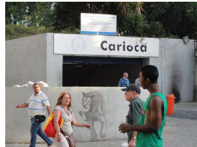
Figura 46. Estação do metrô no largo da Carioca, próxima à rua da Carioca. (29.07.11)
