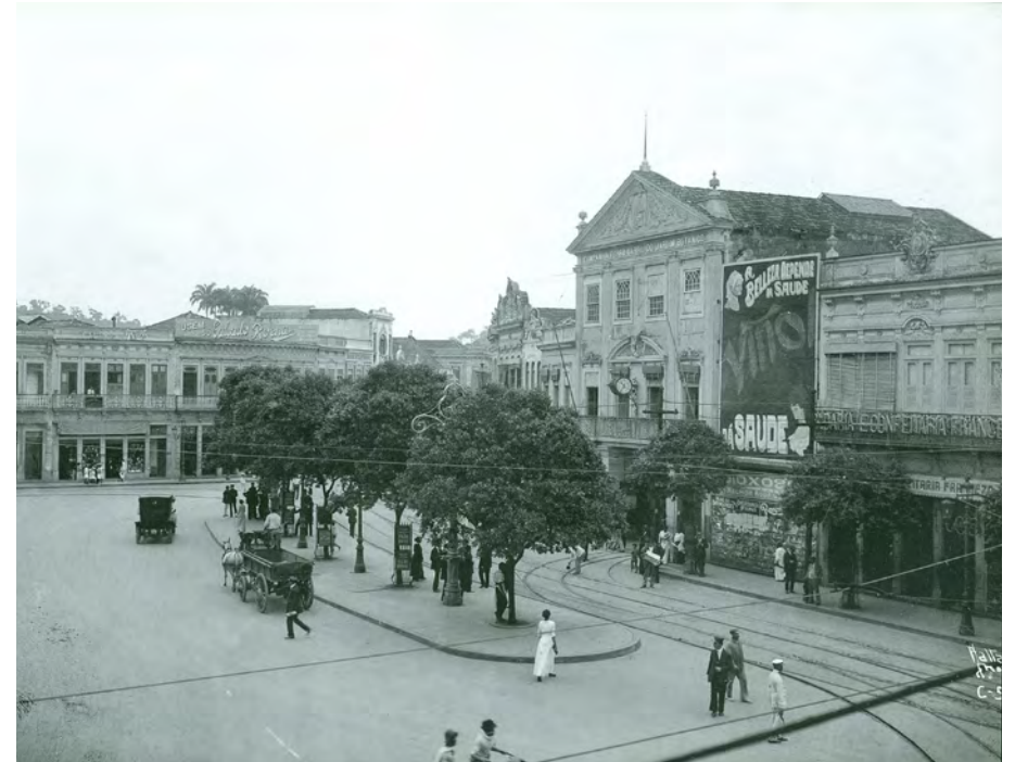
Figura 4. Largo do Machado. Na imagem de Augusto Malta de 1906, várias ocupações das superfícies verticais: a tipografia cuidadosamente aplicada ao edifício da Companhia Ferro Carril do Jardim Botânico; ao lado a grande placa-outdoor cobrindo a fachada; cartazes colados e arrancados um por cima do outro abaixo da publicidade; letras luminosas na padaria e confeitaria; sinalização do ponto de transporte...
