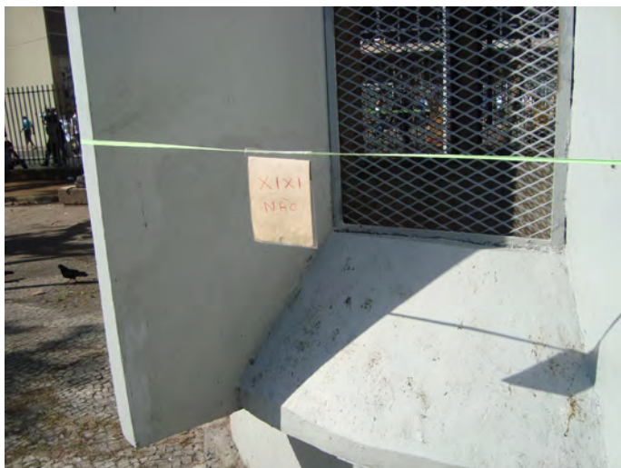
Figura 44. Respiradouro do metrô no largo da Carioca (29.07.11)
